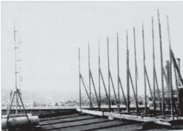
Obr. 2. Celkový pohled na anténu a na konstrukci reflektoru paraboly z nosných tyčí a příček
